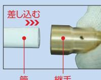
管は、真直ぐに矯正し、管軸に対して直角に切断、矯正ジグで管端を仕上げます。管を継手の奥までしっかり差し込みます。
